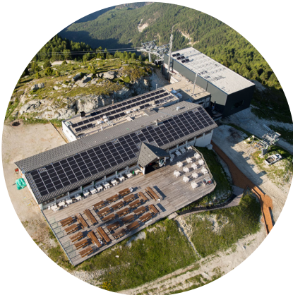
Nouvelle terrasse au restaurant du Crêt-du-Midi
