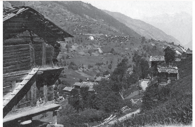
Beispiel eines Speichers oberhalb von Mission, einst
