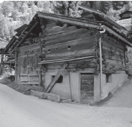
Alte Stallscheune, heute
