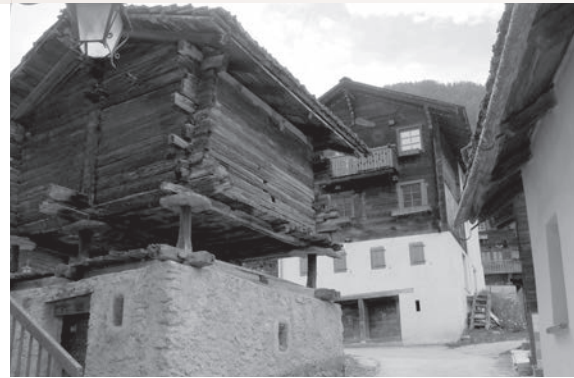
Speicher auf Pfählen, heute
