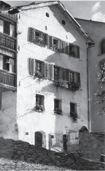
Westfassade der Pfarrei, einstmals
