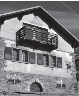
Gebäude der alten Molkerei, heute
