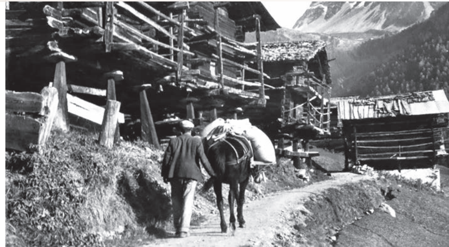
Stadel im Fond-Villa-Viertel, einst
