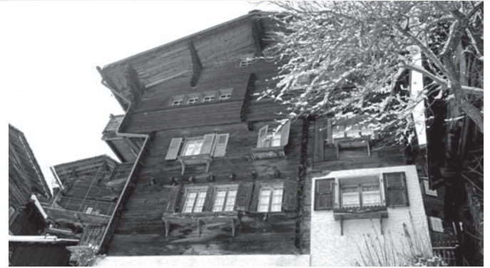
Haus M. im mittleren Saint-Jean
