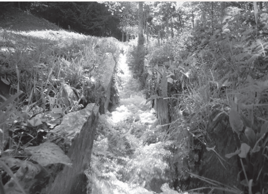
Durchlauf der Grossen Suone zwischen Saint-Jean und Mayoux, im Sommer
