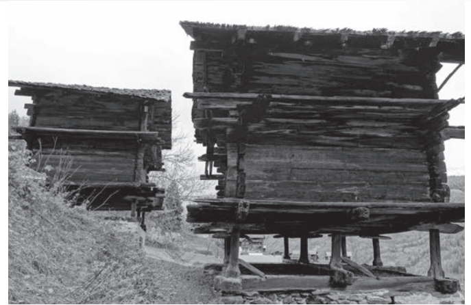
Stadel von Agyrle, Südfassade
