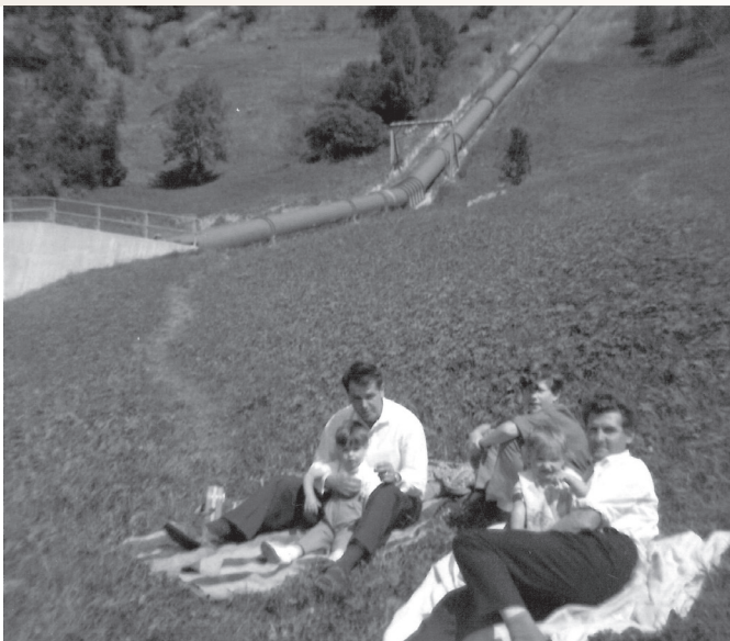
Devant la conduite forcée, dans les années 1960
