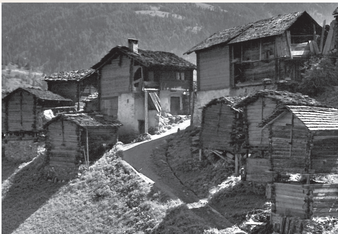
Maison d'école, au centre. Vue prise depuis le nord, autrefois
