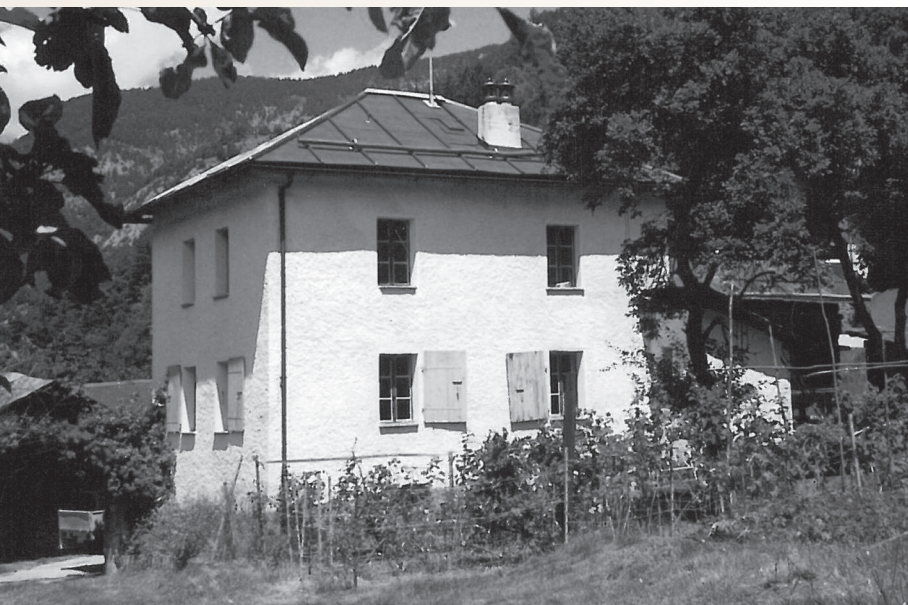
Bâtiment de l'ancienne école
