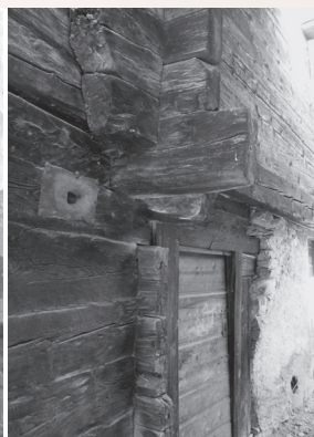
Finition des poutres à la hache
