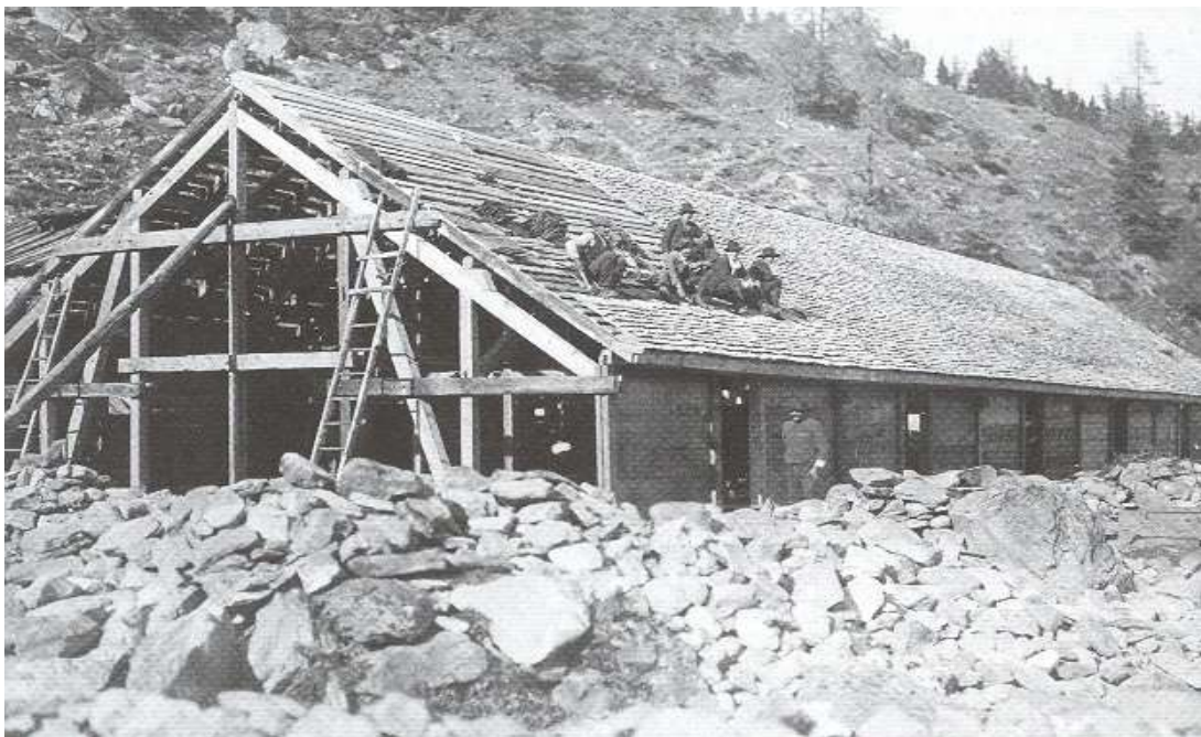
Construction de l'étable sur les hauts de Tortin qui existe toujours – photo datant de 1920
