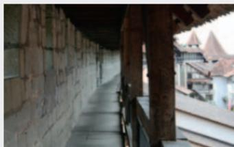
Les remparts ont été construits en plusieurs phases et avec des matériaux différents comme le gravier, le tuf et la molasse. Les 15 premières couches de pierres indiquent que le mur date d'avant la construction de la ville (12<sup>e</sup> s.).
