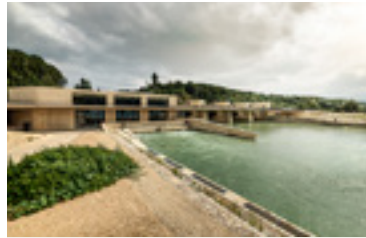
Wasserkraftwerk Hagneck Centrale Hydroélectrique Hydroelectric power plant
