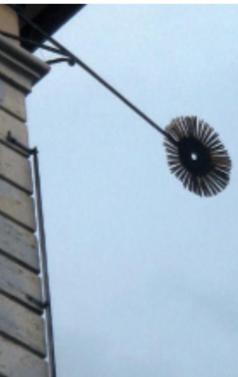
weise aus einem Öhr, das heisst aus einem gelochten, meist dekorativen Diskus, der am äussersten Ende eines Dreibeinmastes angebracht wird. Dieser ermöglicht das präzise Anpeilen der Sonne auf die lotrechte Gradeinteilung.
