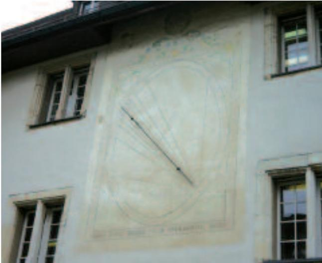
Le cadran solaire méridional : c'est le type de cadran solaire le plus courant, il fait face au sud. Il ne donne l'heure que lorsque le soleil est plus au sud que la ligne est-ouest.
