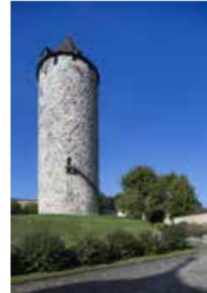
*Der Rundturm mit Kegeldach (16. Jahrhundert) über dem Zinnenkranz wurde wahrscheinlich um 1271 erbaut. Hocheingang zum ersten Stock in ca. 9 m Höhe, ehemals vom Lydda-Gebäude aus über eine Holzbrücke zugänglich. Das Gebäude aus dem 14. Jahrhundert umgab die Basis des Turms und wurde 1804 zerstört. Der Turm ist über eine Treppe begehbar.*
