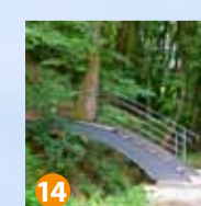
Pont du CPMB Installé en 2011, sur la Ruau, ce pont a été réalisé par des apprentis en constructions métalliques et soudeurs du CPMB, Centre professionnel des métiers du bâtiment, à Colombier.
