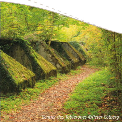
Sentier des Tablerones ©Peter Colberg
