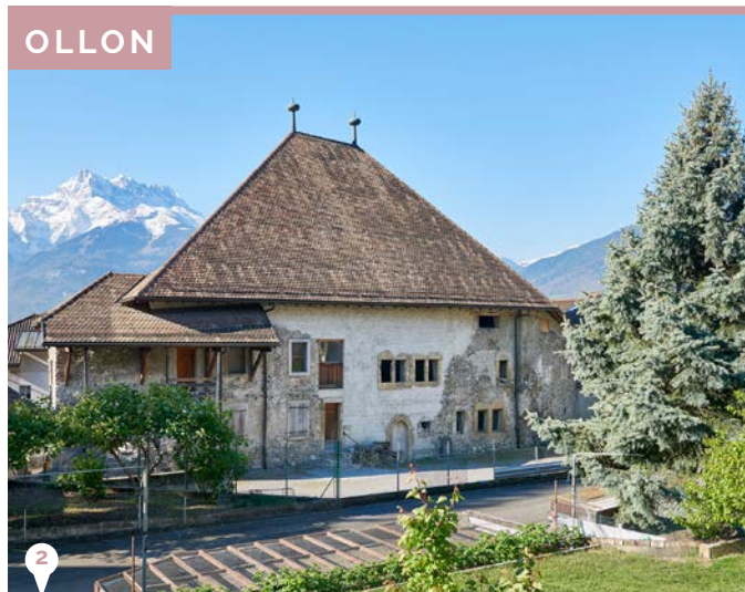
Château de la Roche
