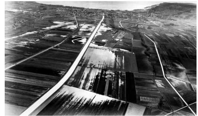
La deuxième correction des eaux du Jura a limité les inondations
