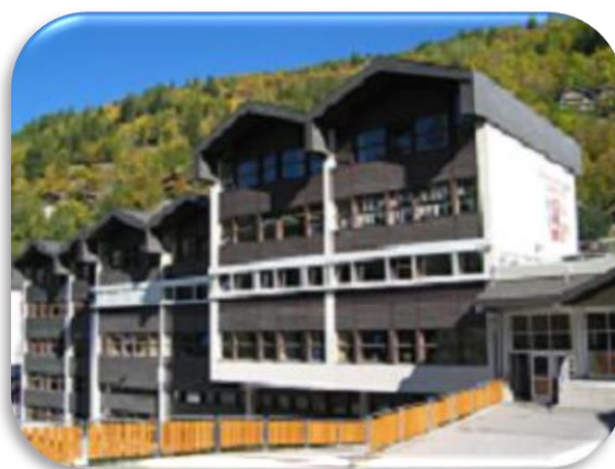
Centre scolaire d'Anniviers
